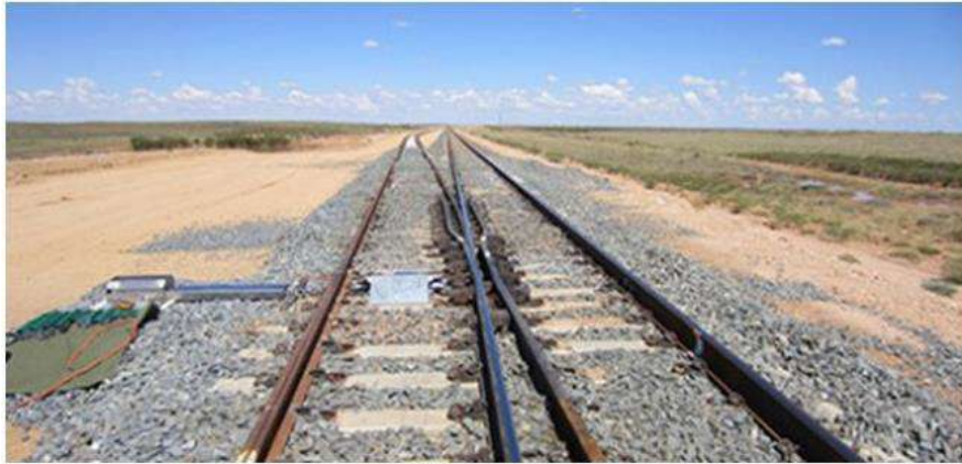
Рисунок 1.3 – Конструкции крестовин с непрерывной поверхностью катания для особо грузонапряженных участков пути
