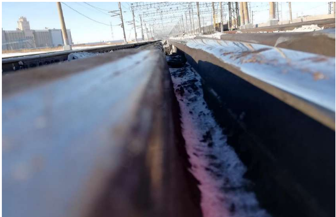
Рисунок 6.2 – Наплывы металла на боковой выкружке клина моноблочной крестовины по кодам ДС.13.2, ДУ.13.2
