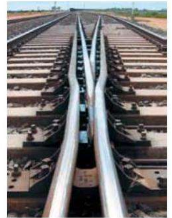
Рисунок 1.3 – Конструкции крестовин с непрерывной поверхностью катания для особо грузонапряженных участков пути
