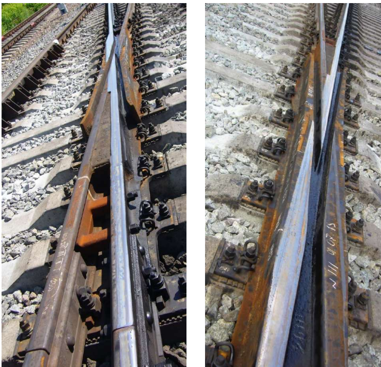
Рисунок 1.7 – Крестовина моноблочной конструкции с четырьмя приварными рельсовыми окончаниями в составе стрелочного перевода типа Р65 марки 1/11 проекта Н01.001
